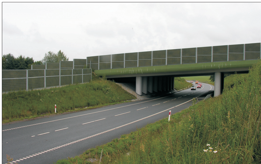
Rys. 5. Właściwie dobrane ekrany akustyczne – droga ekspresowa S69 odcinek Żywiec - Przybędza około km 26+650 (fot. A. Leniak-Tomczyk)
