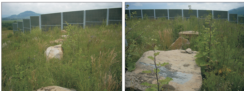
Rys. 8. Narzut z głazów skutecznie uniemożliwiający korzystanie przez ludzi (szczególnie pojazdy, ciągniki, samochody) z przejścia dla zwierząt nad autostradą A4 (fot. A. Leniak-Tomczyk)
