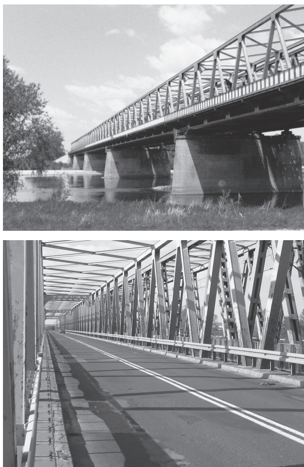
Rys.4. Most przez Wisłę w Nagnajowie Fig.4. General view of Vistula river bridge in Nagnajow
