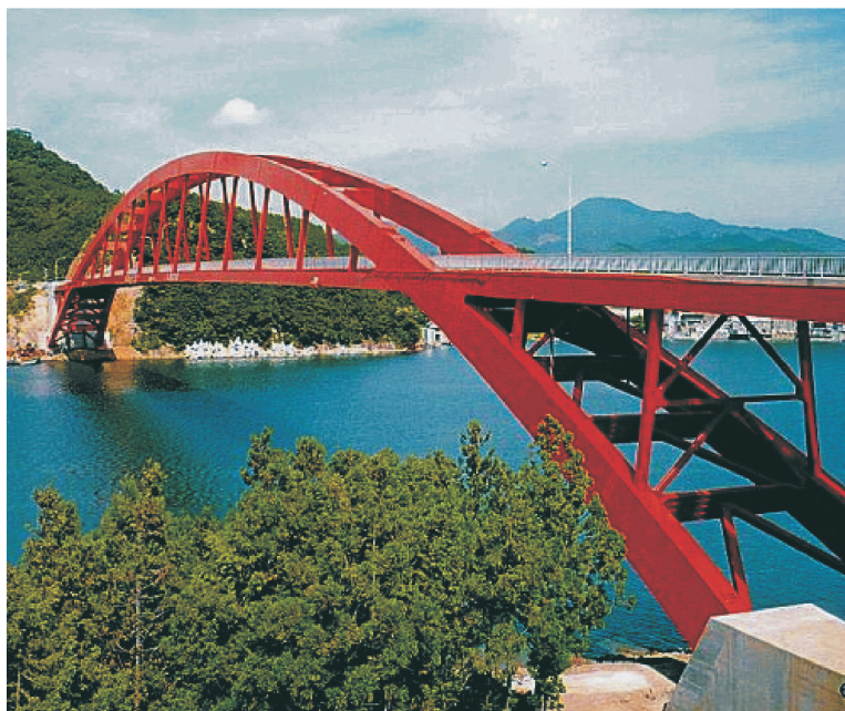
Rys.5. Most Saigo, ( http://www.khi.co.jp/tekkou/catalog/FrameRight6-e.html ). Lokalizacja: Shimane Prefecture, Japonia, długość 270 m, szerokość 6 m, rok oddania 1977
