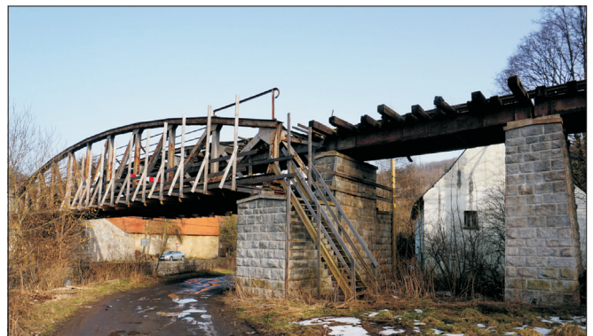
Fig. 6. The multi-span bridges with both deck plate girder and truss span (photo by J. Kania) Rys. 6. Most wieloprzęsłowe z przęsłem blachownicowym i kratownicą (fotografia J. Kania)
