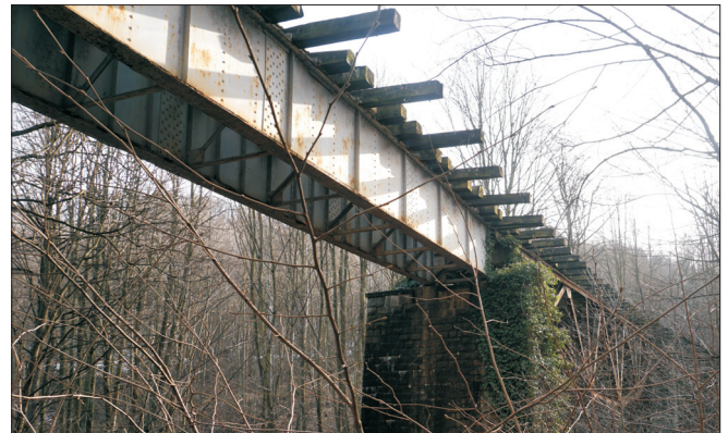
Fig. 5. The deck plate girder span (photo by J. Kania) Rys. 5. Przęsło blachownicowe (fotografia J. Kania)
