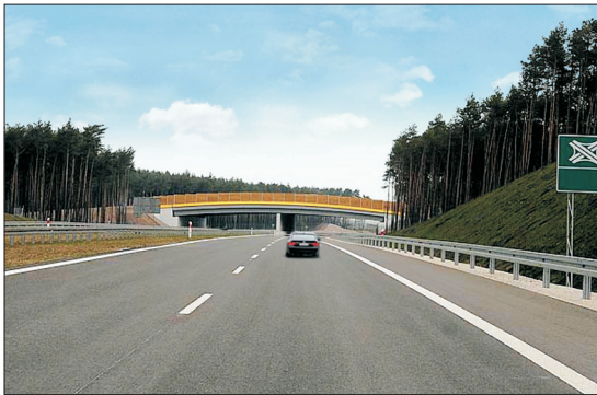
Fig. 4. Expressway S8 – exposed aggregate finish Rys. 4. Droga ekspresowa S8 – technologia „odkrytego kruszywa”
