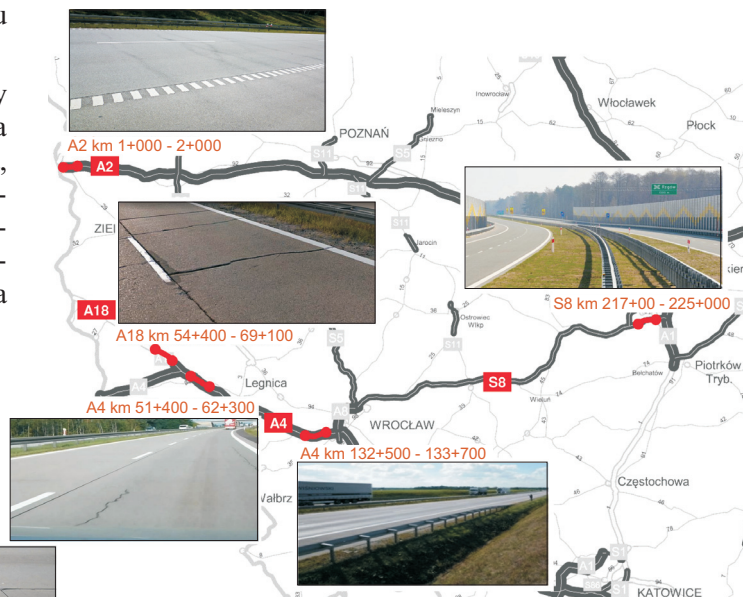
Fig. 2. Locations of trial stretches on which measurements were carried out Rys. 2. Lokalizacja odcinków pomiarowych nawierzchni betonowych
