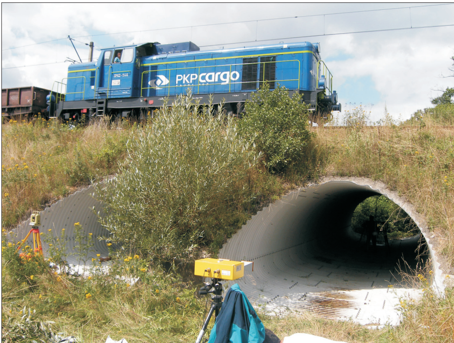
Rys. 3. Widok z boku na przepust kolejowy podczas badań doświadczalnych z wykorzystaniem radaru interferencyjnego
