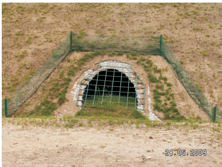
Rys. 7. Przejście dla płazów pod autostradą A4 wybudowane w ramach programu Natura 2000
